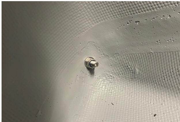
2. Mit M5x16 Schrauben von außen, dann innen: 10mm Unterlegscheibe und Stopfmutter anschrauben
